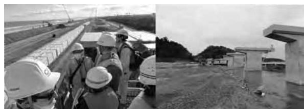
仙台湾南部海岸堤防復旧工事現場の視察(左) (株)長大殿のご案内で訪問した被災橋梁現場(右)
