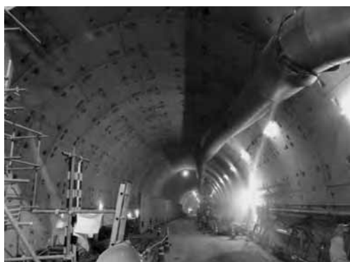
写真3 建設中のシールドトンネル内部
