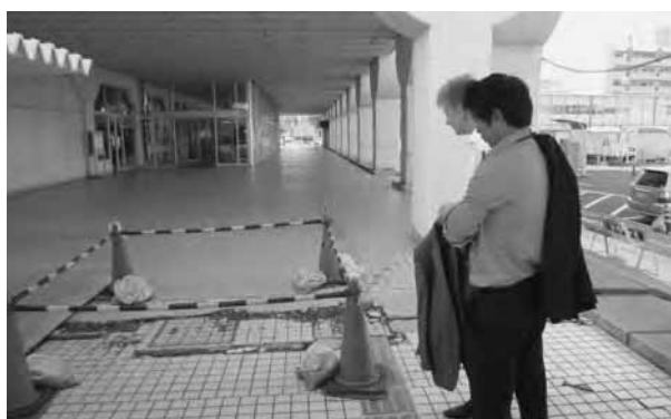
写真2 液状化による地盤沈下（水戸市）
